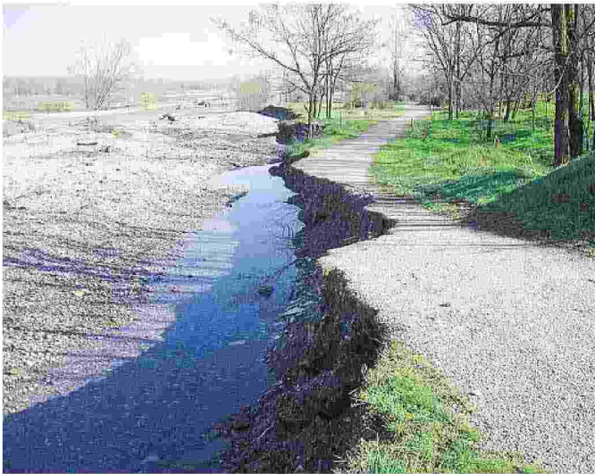
Le sponde del fiume Serio in stato di evidente erosione
