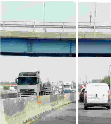
Cantiere. I lavori in corso sulla Tangenziale Sud di Brescia
