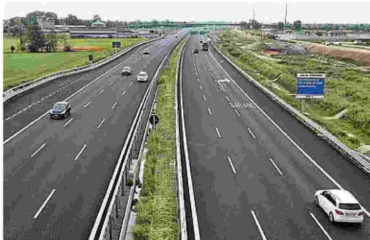
Autostrada Brebemi , l'arteria che con un tracciato di 62 chilometri collega le province di Milano e Brescia passando per la Bassa Bergamasca, è stata inaugurata un anno fa
