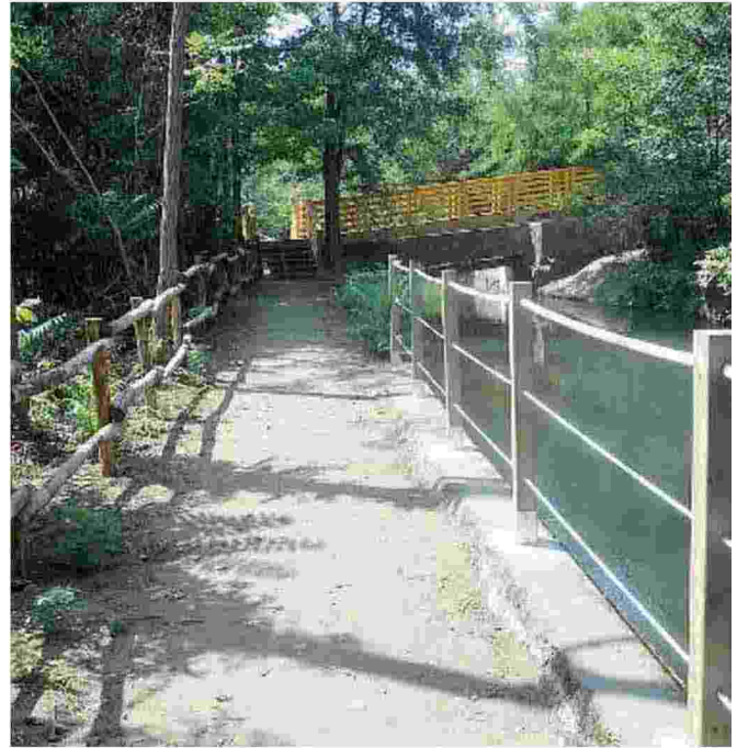
Ciclabile. Nuovo ponticello e lavori di sistemazione sulla pista a Palosco
