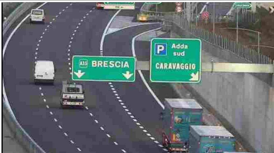
Brebemi | l'autostrada A35
