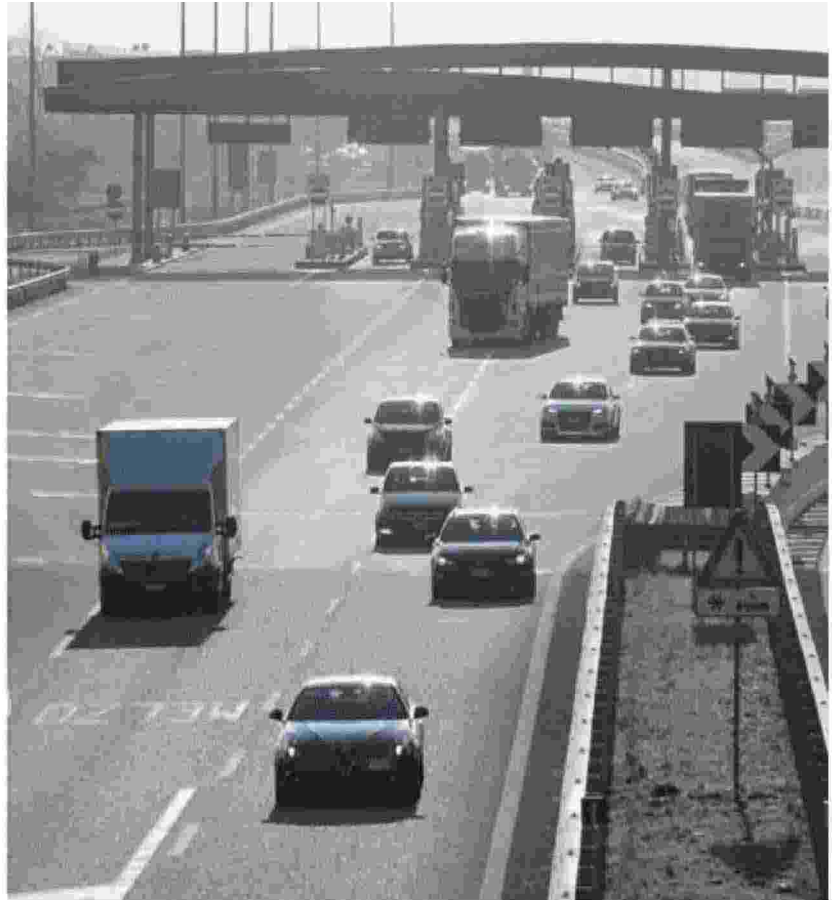
La A35 Brebemi sarà la prima autostrada elettrica d'Italia grazie alla collaborazione con il Politecnico
