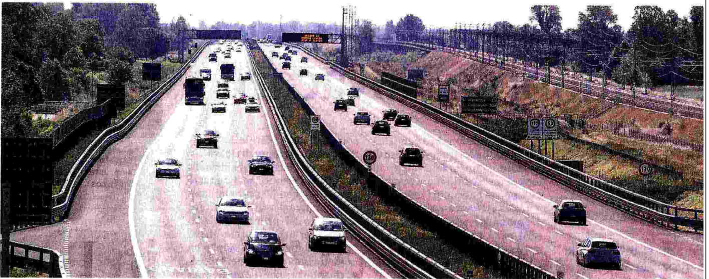
Infrastruttura strategica. Un'immagine della Brebemi , la direttissima autostradale Brescia-Milano. L'arteria collega tre province: Milano, Bergamo e Brescia
