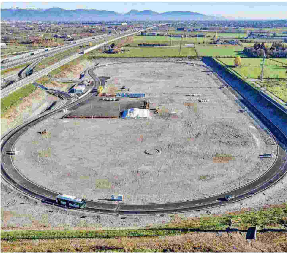
«Arena del Futuro». Il circuito a sud di Chiari, lungo la Brebemi, dove si sperimenta il nuovo sistema di ricarica
