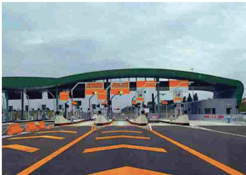
Un casello dell'autostrada A35 Brebemi
