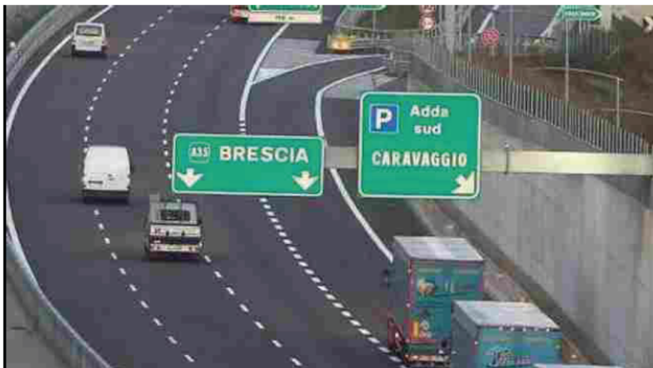
Brebemi , l'autostrada A35
