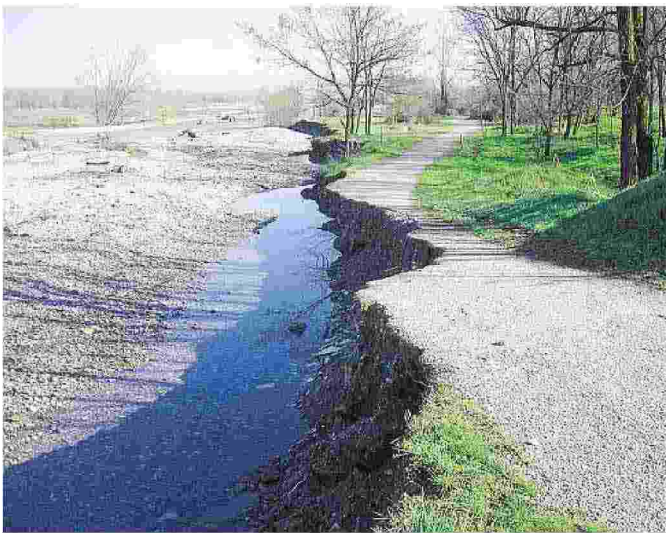
Le sponde del fiume Serio in stato di evidente erosione
