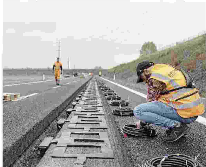
Tecnologia. Le spire affogate nell'asfalto per la ricarica
