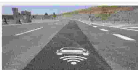
Questa tecnologia permette ai veicoli elettrici di ricaricarsi viaggiando grazie ad un innovativo sistema di spire
