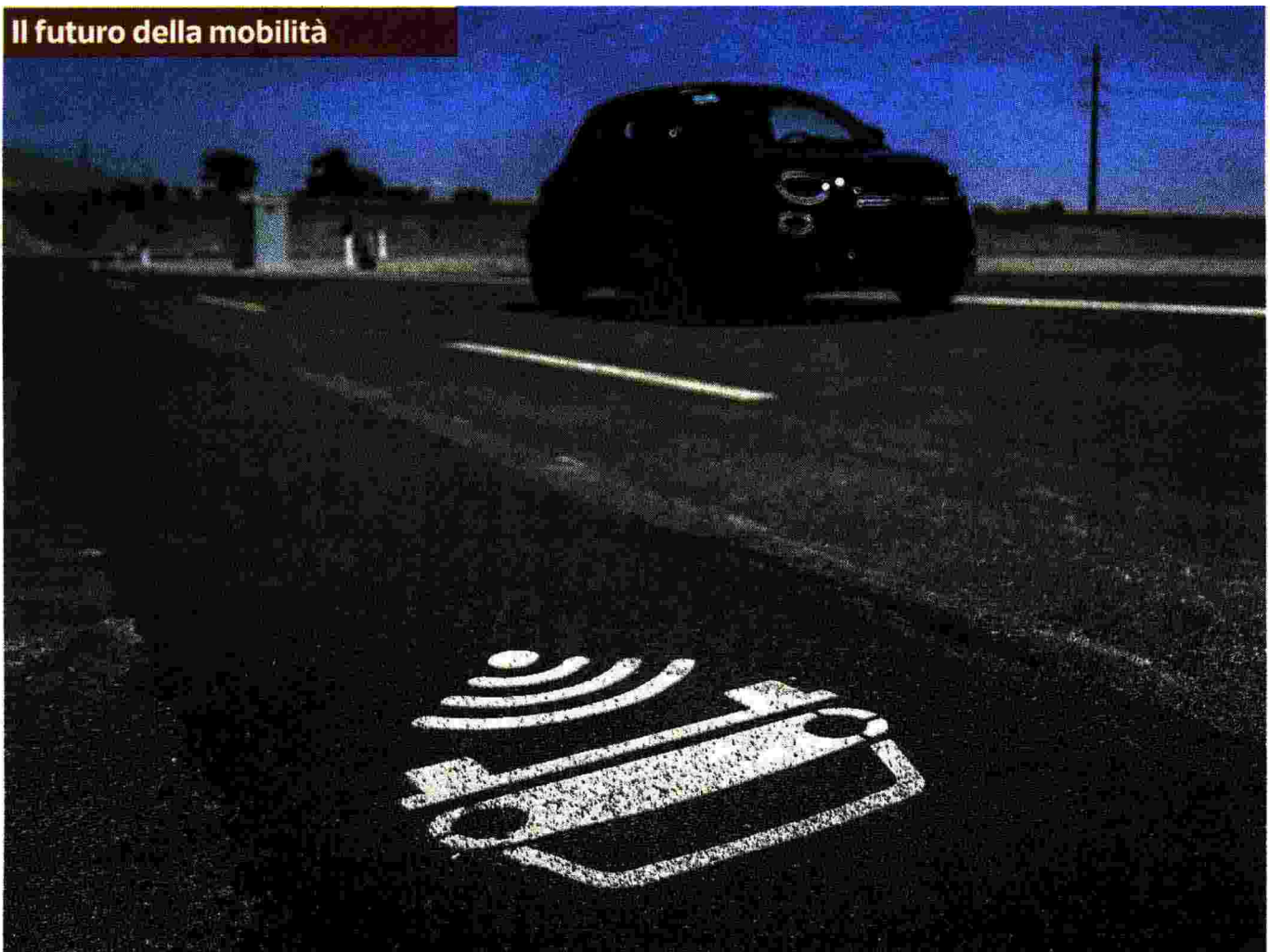
La tecnologia Una 500 mentre percorre l'anello d'asfalto denominato «Arena del futuro» a Chiari, dove è stato installato il sistema Dwpt (LaPresse)
