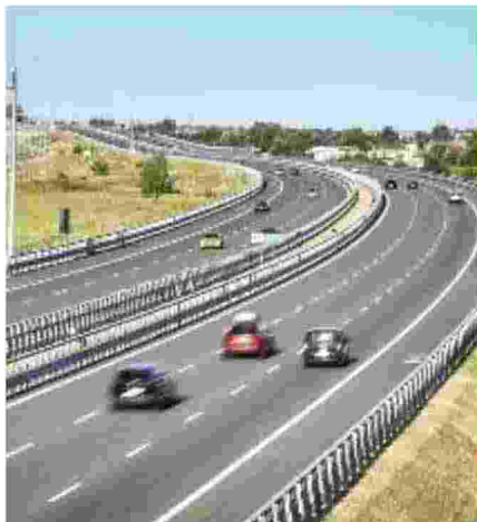
L'autostrada A35 Brescia-Bergamo-Milano
