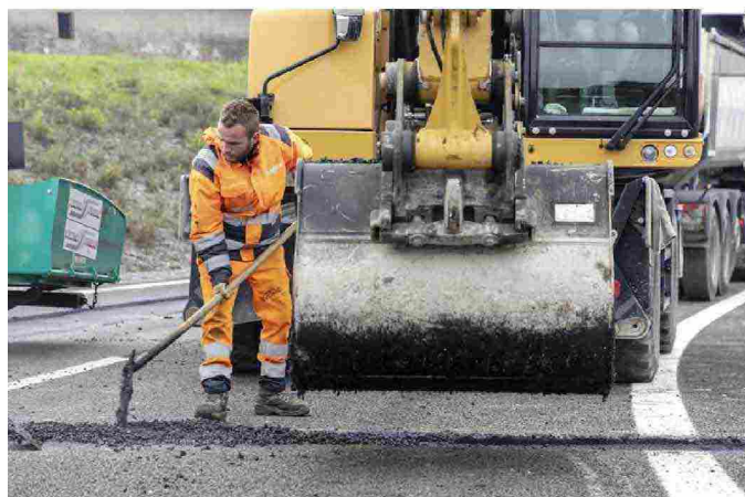
5. Sulla A35 Brebemi il nuovo asfalto Mapei incorpora il 25% di materiale riciclato, con prestazioni monitorate costantemente
